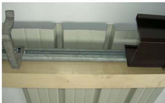
Befestigungssystem mit Halfenprofile auf der Wand!
